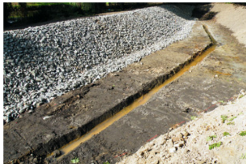
Odcinek Thostgrundbach dawniej ujęty kanałem podziemnym
