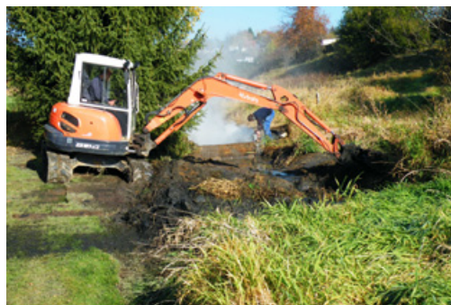
Prace w toku, wrzesień 2011 r.
