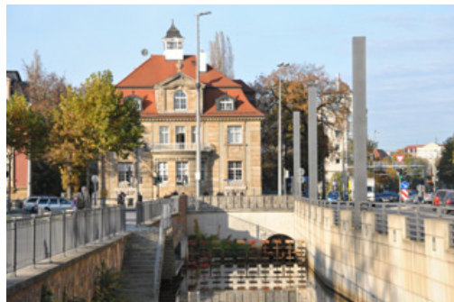
Urządzenia spiętrzające wodę na jazie Nonnenmühlwehr
