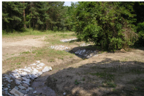
W trakcie rewitalizacji w lipcu 2007 r.
