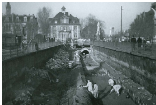
Przepusty na Pleiße-mühlgraben w 1954 r.
