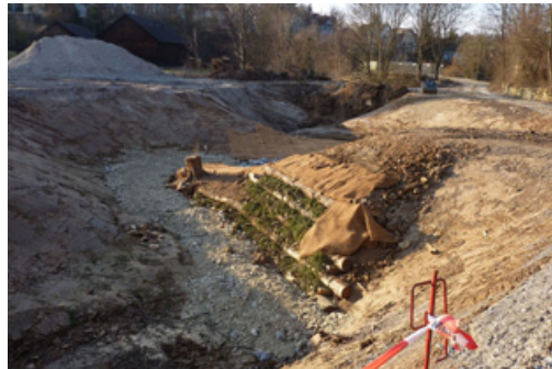
Teren inwestycji – rozwiązania bioinżynieryjne
