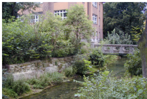
Stan przed rewitalizacją w 2001 r.
