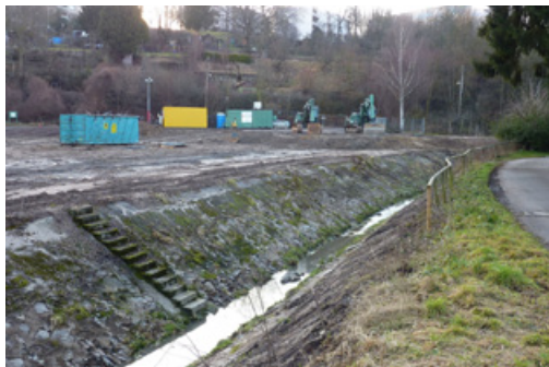
Prace budowlane w styczniu 2012 r.
