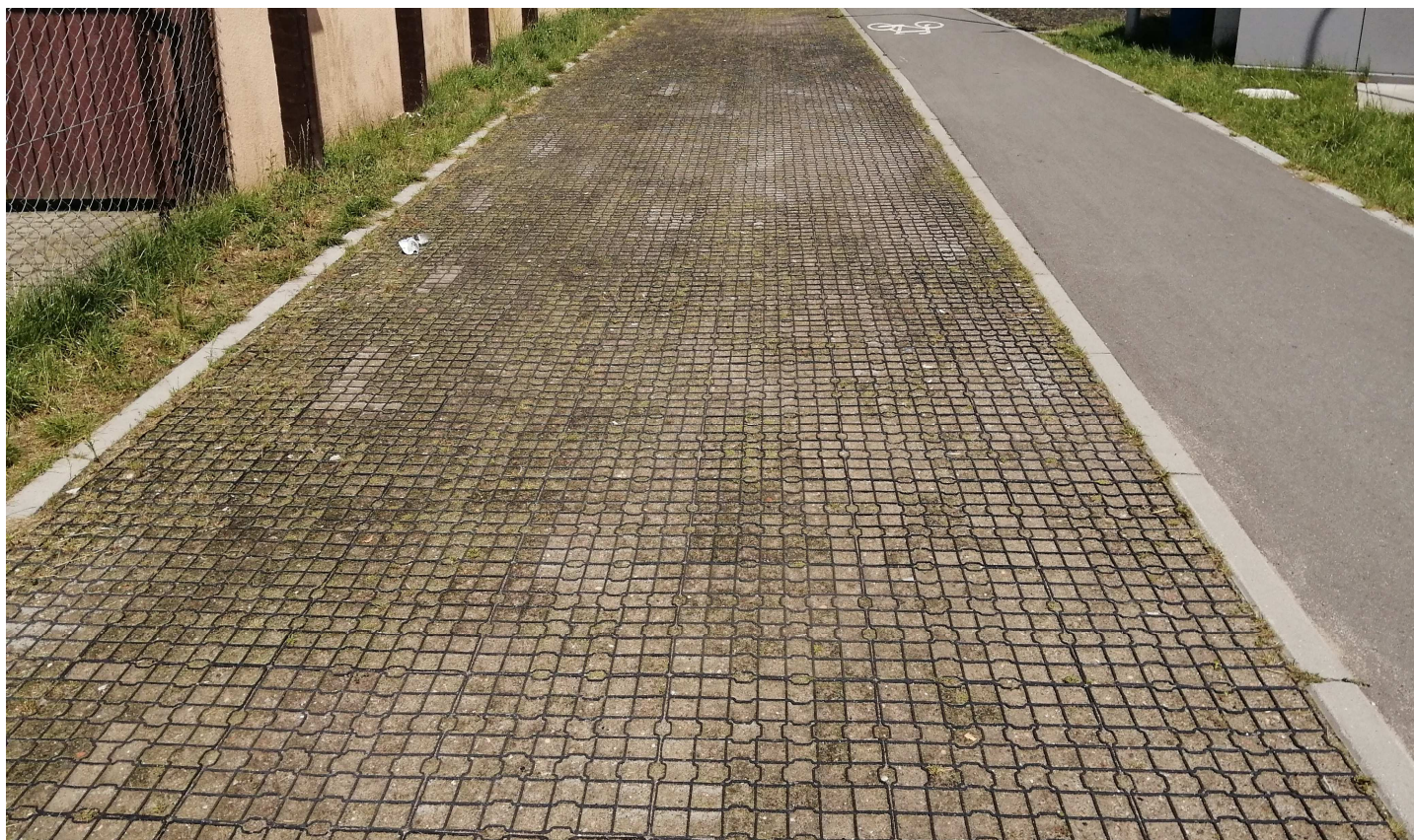
Fot. 1 Stabilizacja terenu geokratą.
