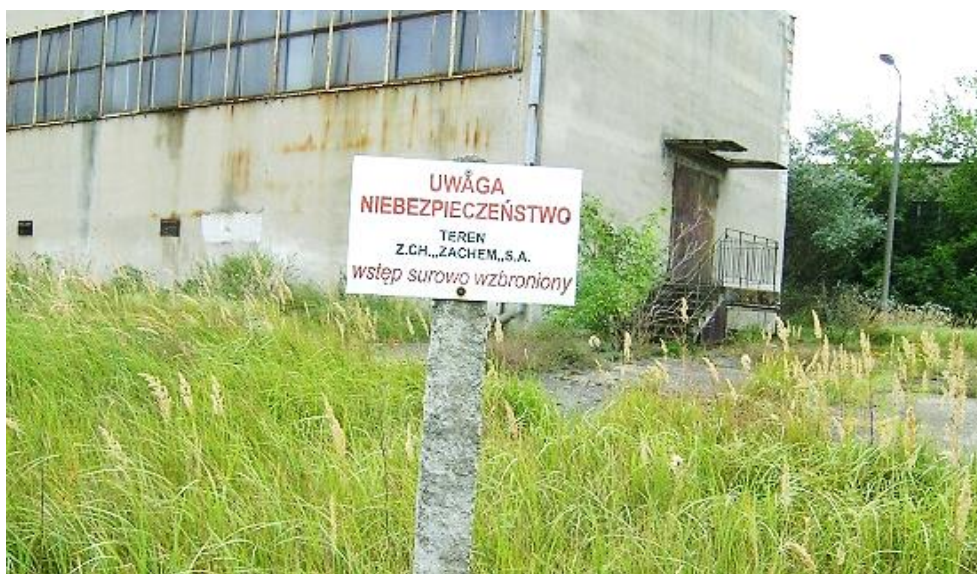
Fot. 10. Infrastruktura pozostała po Zakładach Chemicznych (fot. D. Pierri)
