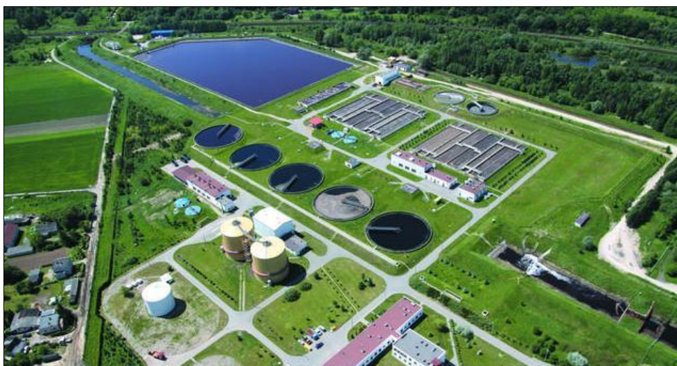
Fot. 8. Oczyszczalnia ścieków „Kapuściska” w Bydgoszczy (źródło: www.chemwik.pl )
