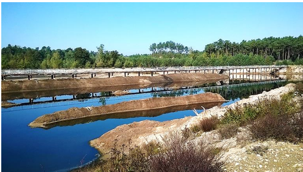
Fot. 5. Składowisko odpadów „Zielona” na terenie ZCh „Zachem” – część ISO (2) (fot. D. Pierr)
