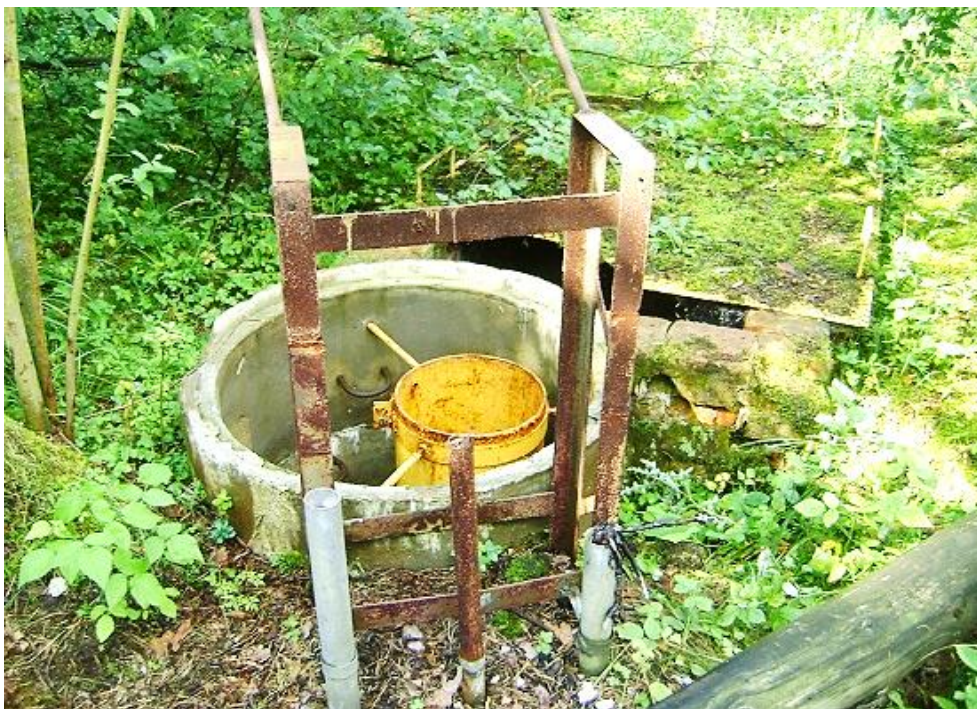
Fot. 11. Stara studnia głębinowa S6 zaadaptowana na piezometr (fot. D. Pierr)
