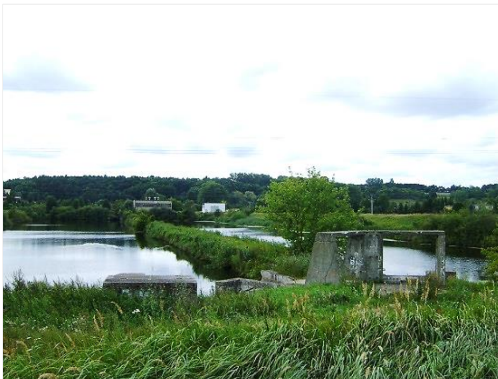
Fot. 9. Centralny Zbiornik Uśredniania Ścieków (fot. D. Pierri)
