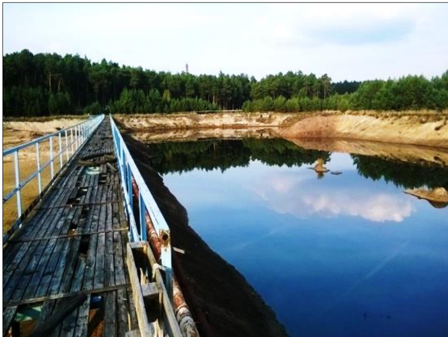
Fot. 8. Składowisko odpadów przemysłowych „Zielona” na terenie „Zachemu” (1) (fot. D. Pietrucin)
