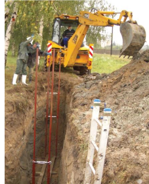
Hydrogeotechnika Sp. z oo Ścianka szczelna Remediacja.
